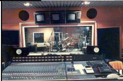
Εργαστήριο Τηλεπικοινωνιών - Μονάδα Ηλεκτρακουστικής
